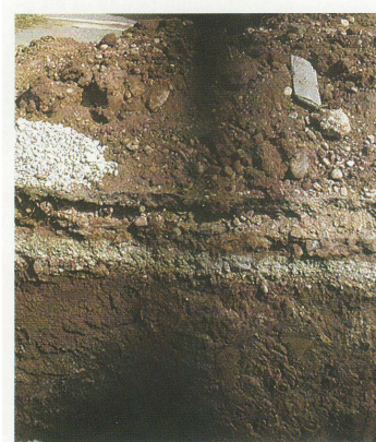
Scavi in mezzo al ponte della Madonna: vedi i vari strati di strade e poi... terreno paludoso.
